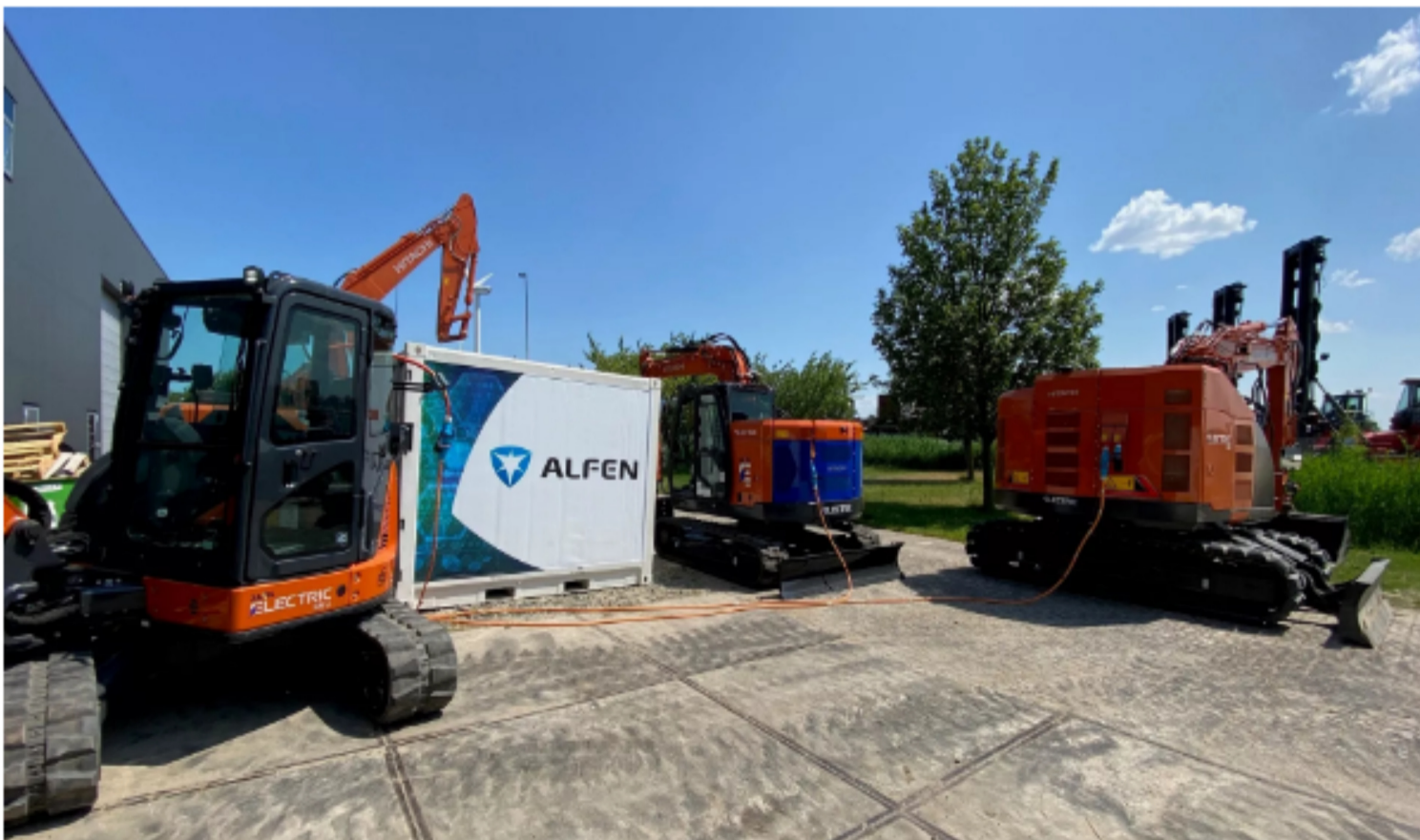
アルフェン社の可搬式充電設備から給電する日立建機のバッテリー駆動式ショベル
