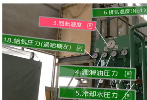
HoloLens 2装着時のイメージ(選択した点検箇所が表示される様子)
